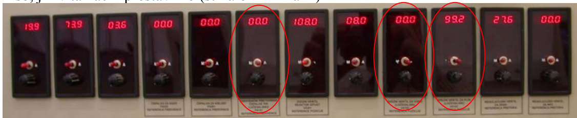
Slika 8 Stikala za preklp iz ročnega v avtomatsko delovanje
