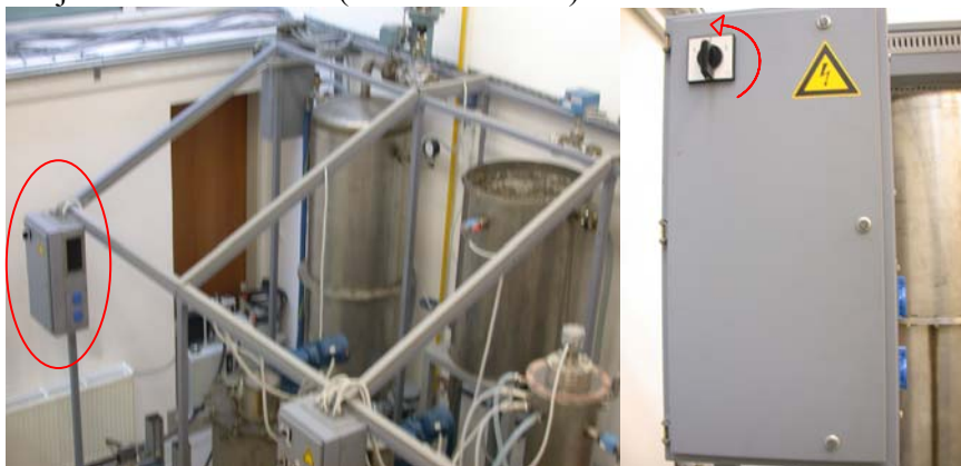
Slika 4 Omarica s frekvenčnim pretvornikom Mitsubishi FR-E500
